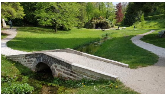
Le pont Paul Lamarche, 38 ème pont de Paris
